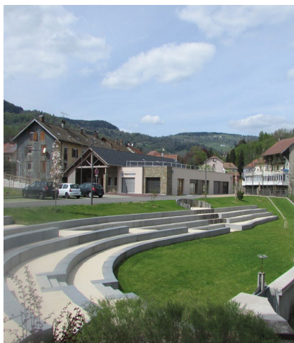
Nouvel amphithéâtre de plein-air de Cornimont © Bernard Villemain
